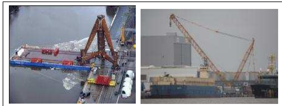
Abbildung 15: Tripodenverladung per Ponton der BLG und per Schwimmkran im Labradorhafen
