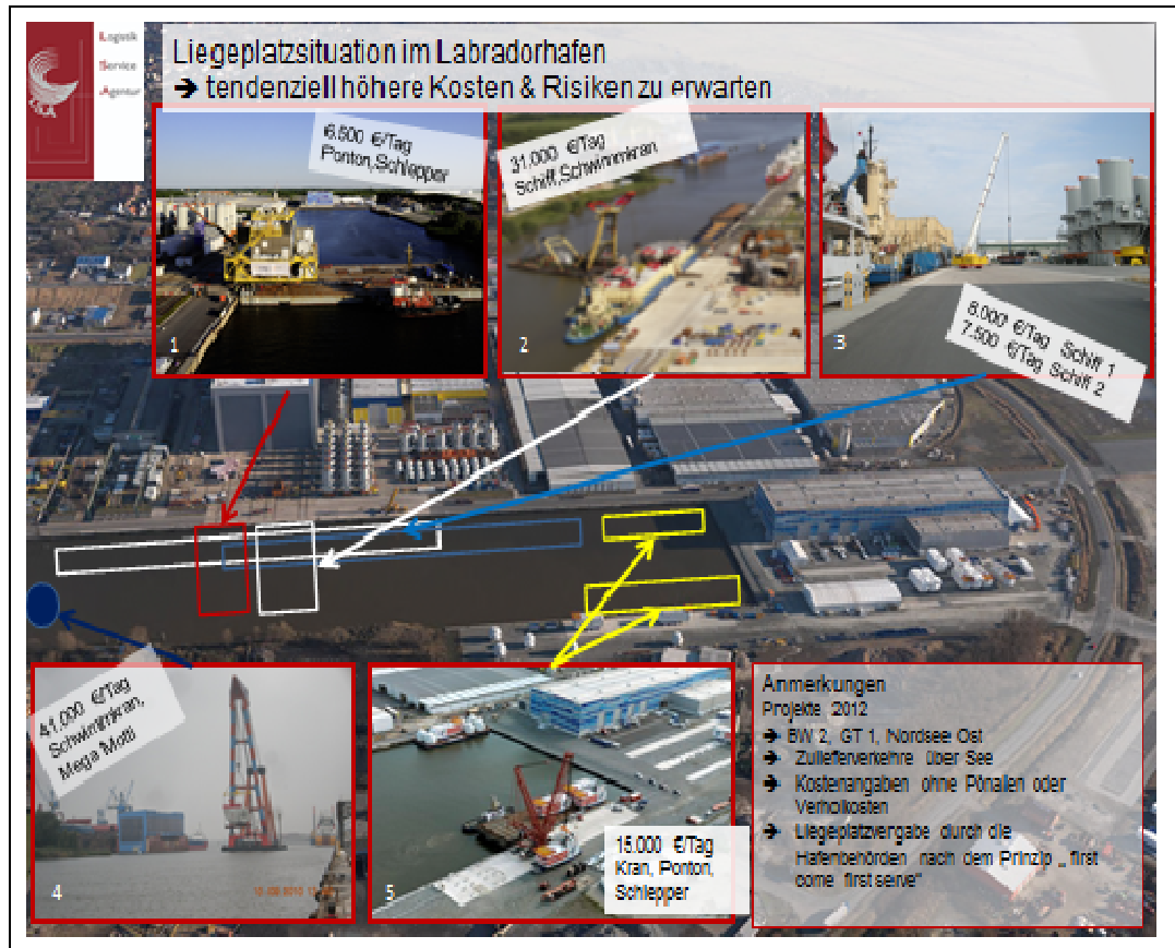
Abbildung 16: Übersicht über die aktuelle Liegeplatzsituation im südlichen Labradorhafen
