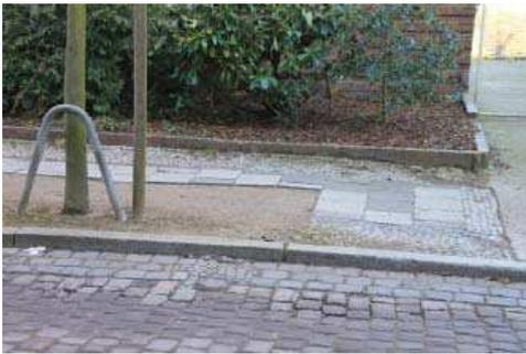
Insbesondere entlang der Grenzen zu den Privatgrundstücken sind bei Eingriffen in den Bestand, z.B. im Zuge von Neugestaltungen der Hauszugänge oder mit dem Einbau von Abfallbehältern, die alten Mosaikpflasterungen häufig nicht ordnungsgemäß wiederhergestellt worden. An einigen Stellen fehlen die Grundstückseinfassungen aus Klinkerrollschichten oder Sandsteinborden.
