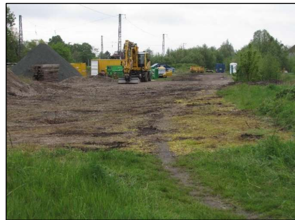
Abb. 4: Bauplatz im Osten
