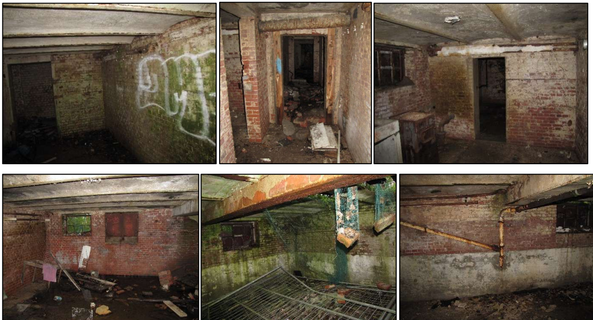
Abb. 12: Eindrücke der Kellerräume
