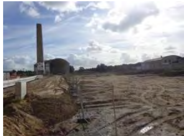
Abbildung 9: Baumaßnahmen am Kistner-Gelände (2019)
