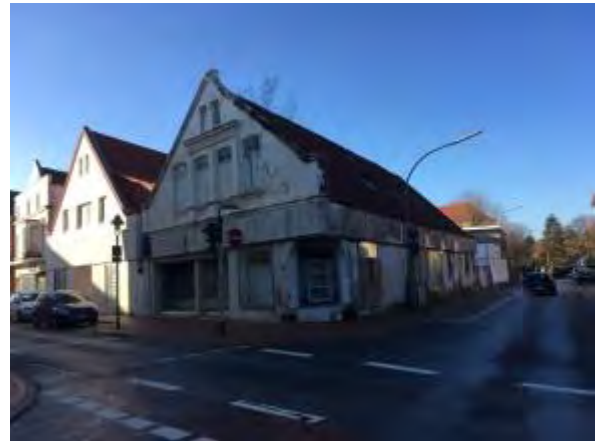
Abbildung 48: Schrottimmobilie an der Langen Straße
