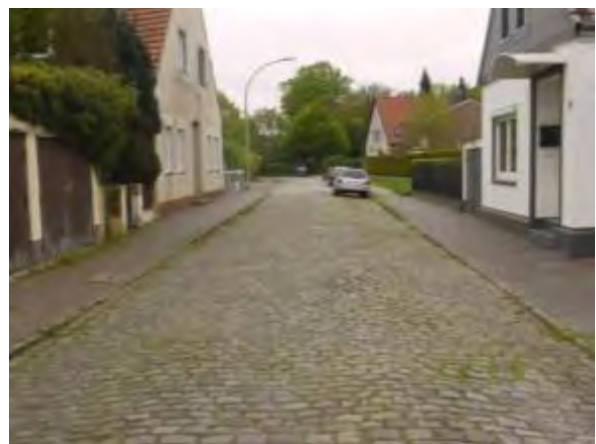
Abbildung 72: Kopfsteinpflaster in der Nettelstraße
