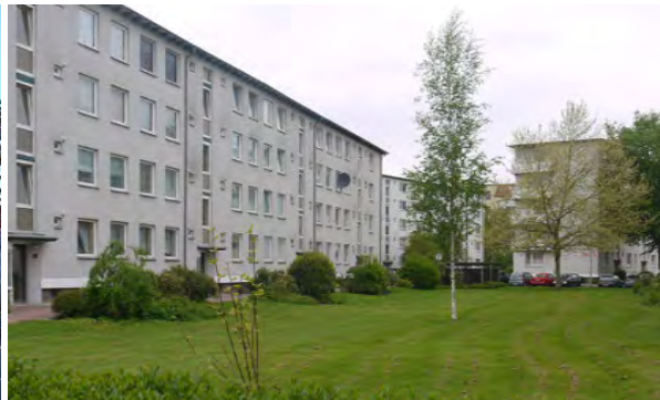
Wohnsiedlung im Westteil
