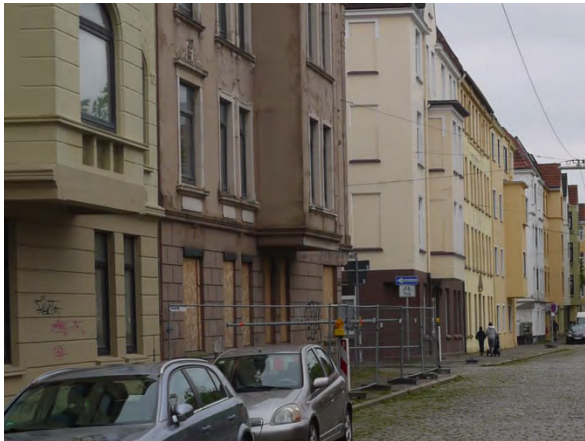
Abbildung 47: Sanierungsbedürftiger Altbau im Goethequartier
