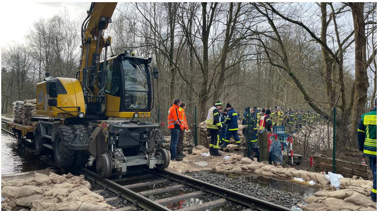
Schweres Gerät an der Einsatzstelle, Bildnachweis THW
