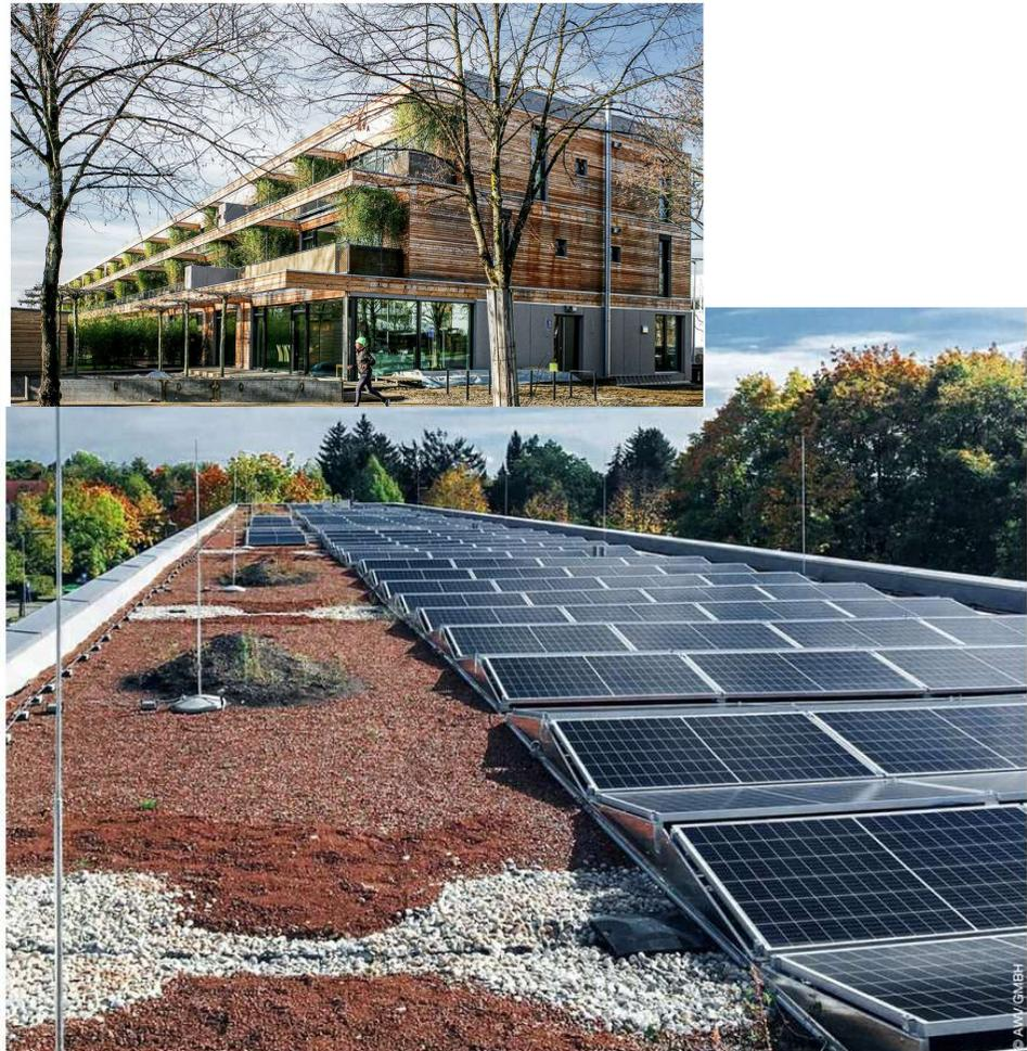
Dank guter Dämmung, einer Luft-Wasser-Wärmepumpe und der PV-Anlage funktioniert der Neubau über weite Teile des Jahres autark.
