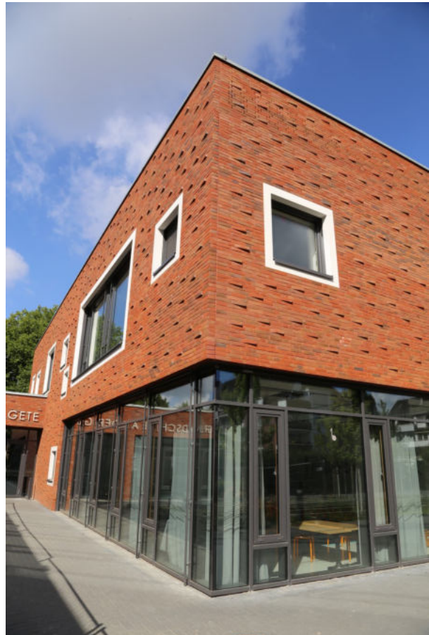
Neubau Schule An der Gete
