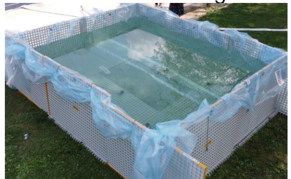
Wasserreservoir für die Brandbekämpfung Görlitz, Deutschland
