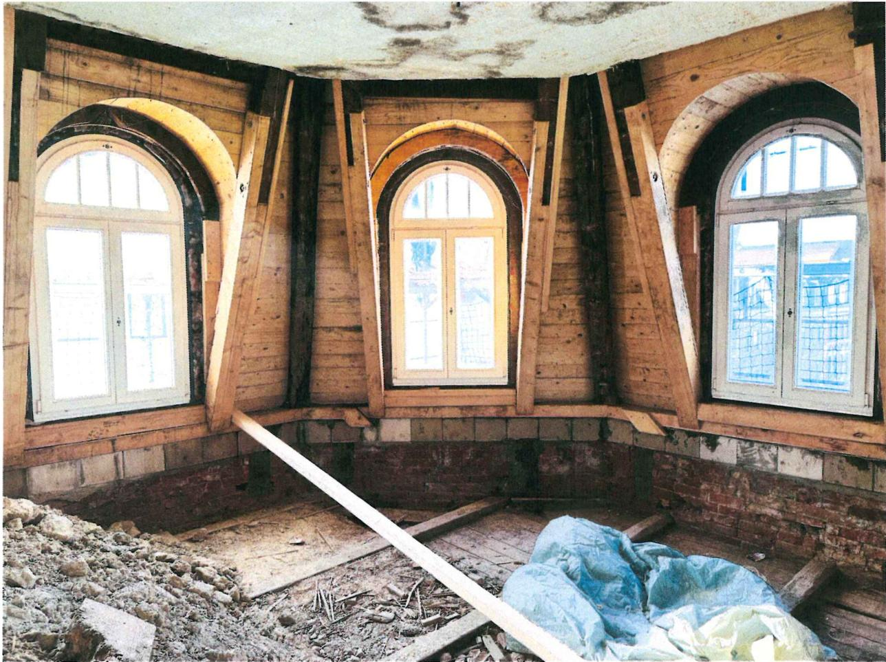
Austausch der Dachkonstruktion nach ehemaligem Brand.
