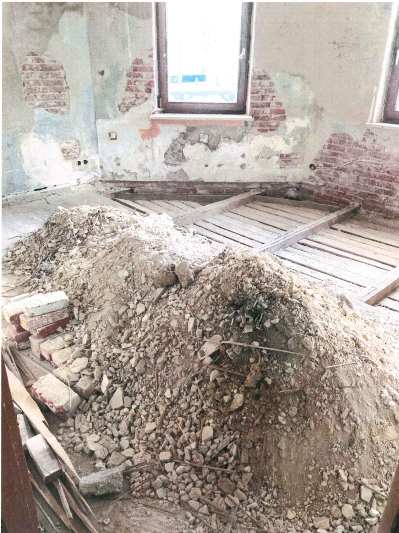
Freilegung sämtlicher Balkenköpfe: hier Aufnahme der alten Lehnschüttung
