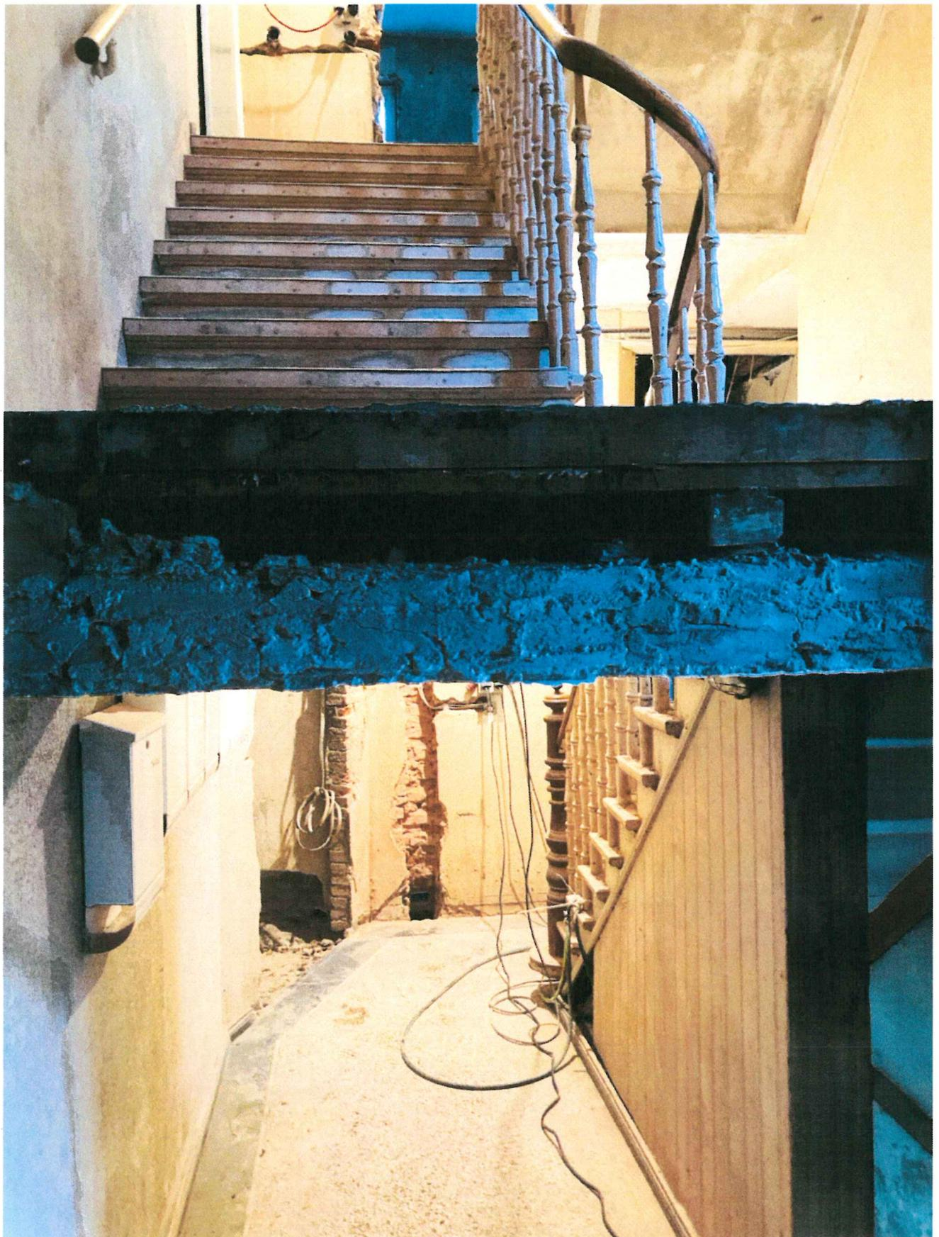
Notwendiger Umbau der alten Geschosstreppen aufgrund Einbau Aufzugsschacht ins bestehende Gebäude
