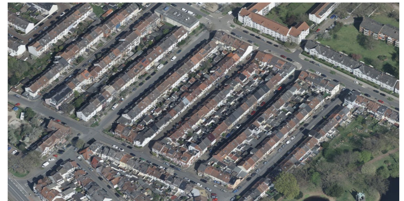
Abb. 12 Mit einer hohen baulichen Dichte und wenig Durchgrünung gehören weite Teile Gröpelingens zu den hitzebelasteten Siedlungsbereichen Bremens
