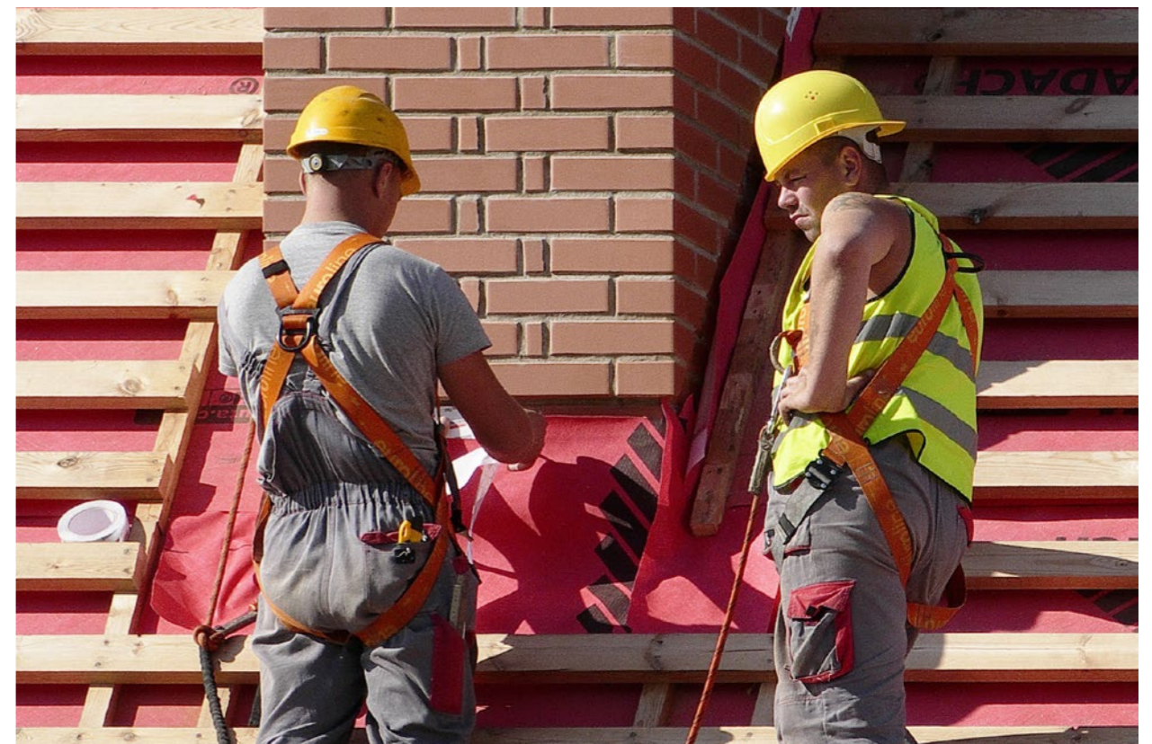
Abb. 20 Für körperlich im Freien arbeitende Personen besteht eine erhöhte Gefährdung gegenüber Hitzebelastungen
