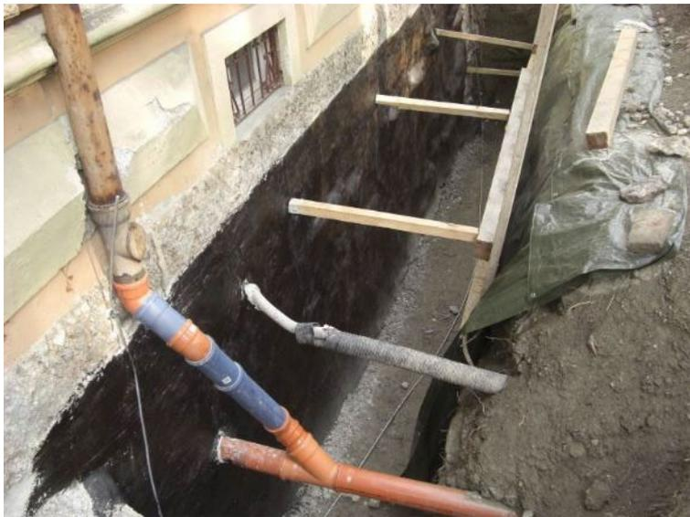
Die Vertikalabdichtung verhindert das Eindringen von Feuchtigkeit durch die Außenwände des Kellers. Sie wird insbesondere bei Neubauten eingesetzt, kann aber auch nachträglich bei Bestandsgebäuden installiert werden. Dabei erfolgt die Abdichtung entweder von außen durch das Freilegen der Kellerwände oder von innen, wenn eine Außenabdichtung baulich nicht möglich ist.
