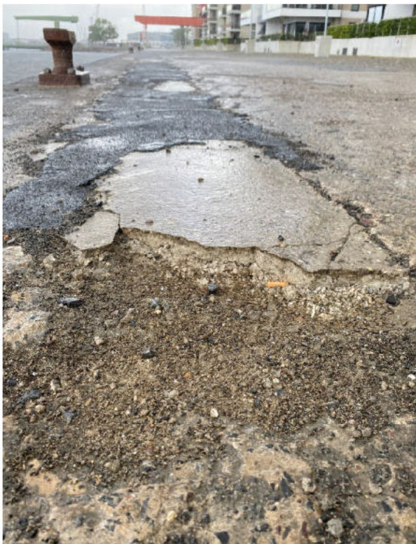
Abb. 7: Nordostkaje, Beispiel Stolperfalle, erodierter Beton
