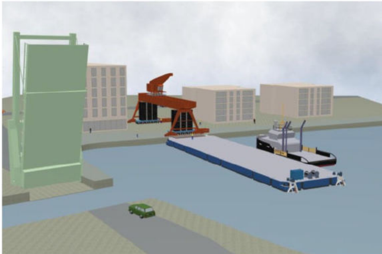
Abb. 10: Portalkran wird mit Hubwägen angehoben und hinderliche Kranschienen werden demontiert
