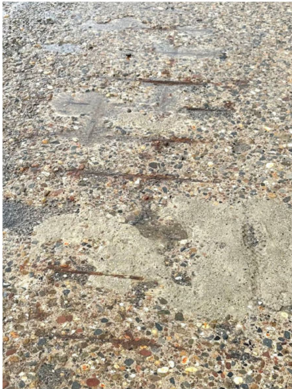
Abb. 5: Nordostkaje, Beispiel Stolperfalle, freiliegende Bewehrungsstäbe
