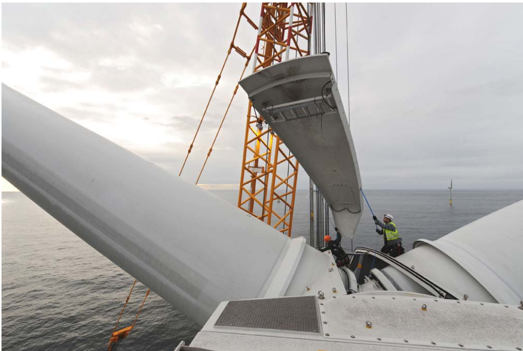
Montagearbeiten am Rotorkranz einer Windenergieanlage im Testfeld Alpha Ventus. Foto: Jan Oelker, REpower Systems AG
