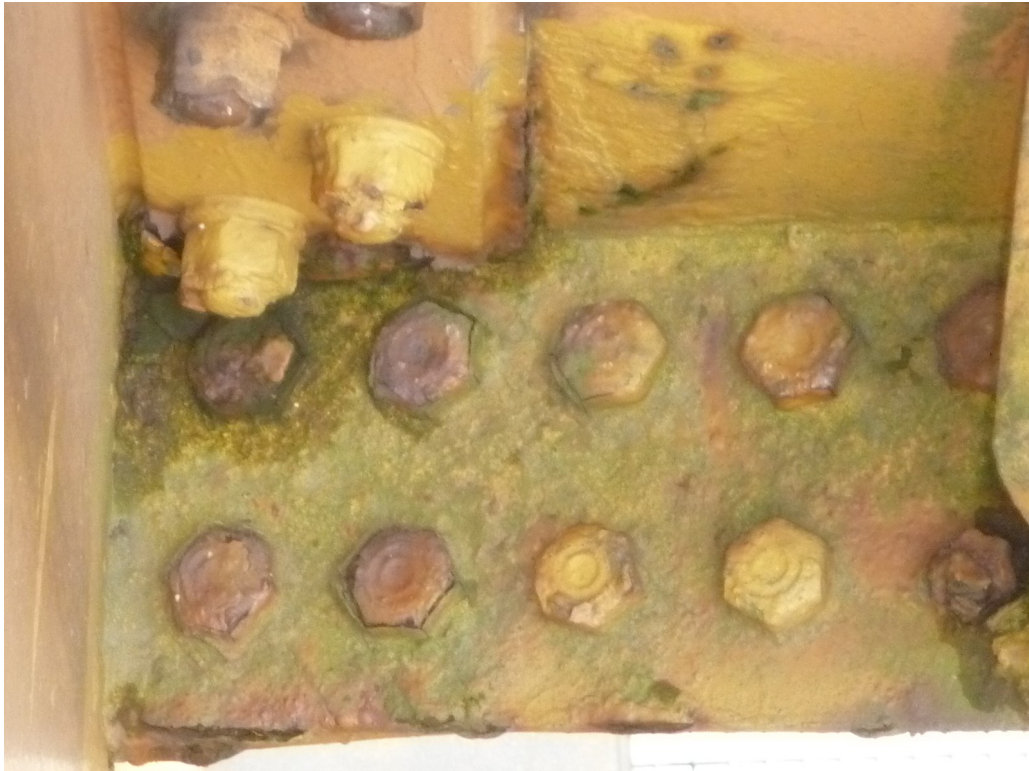
Schraubenkorrosion
