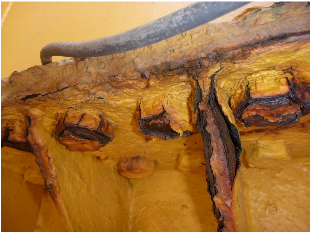
Schraubenkorrosion
