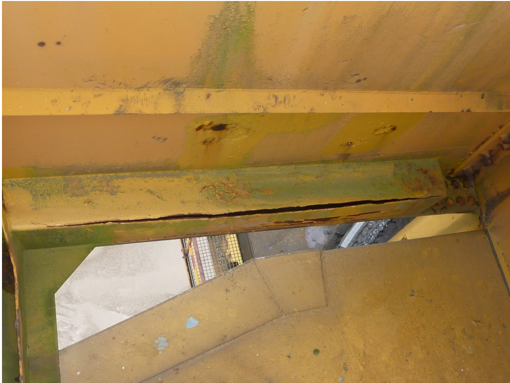
Aufgerissener Untergurt des Kranauslegers
