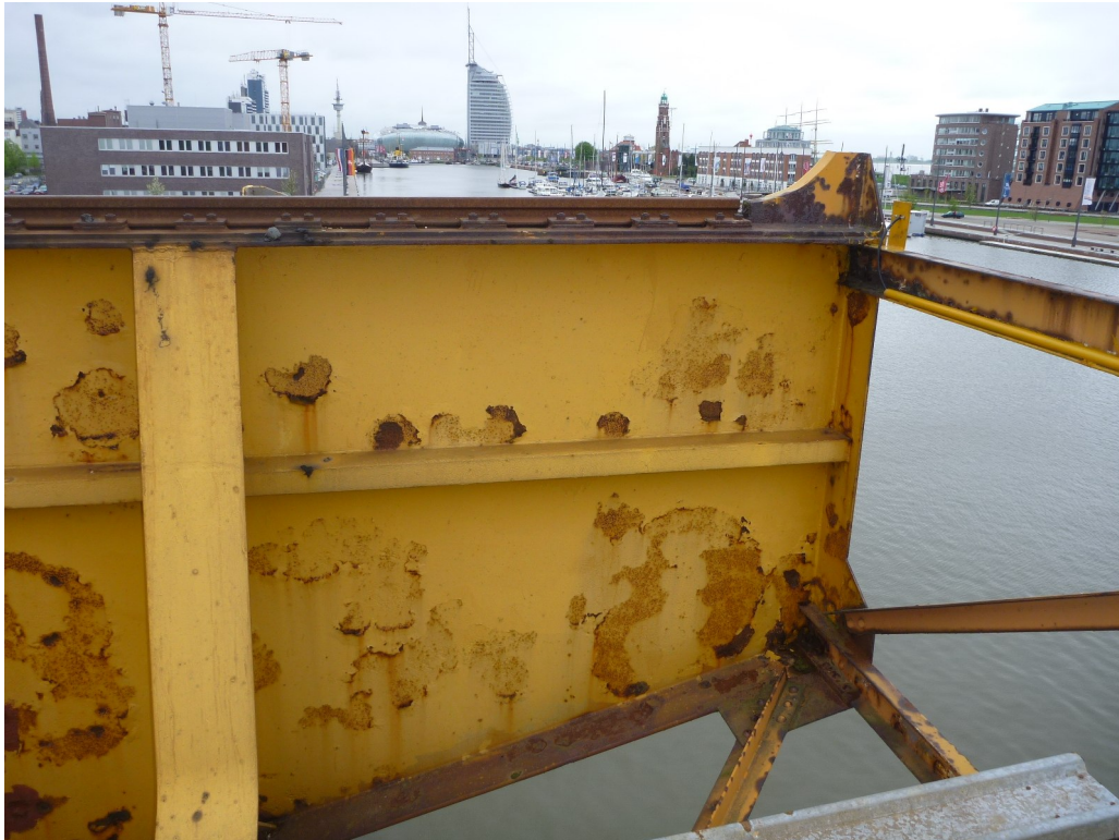
Oberflächenkorrosion
