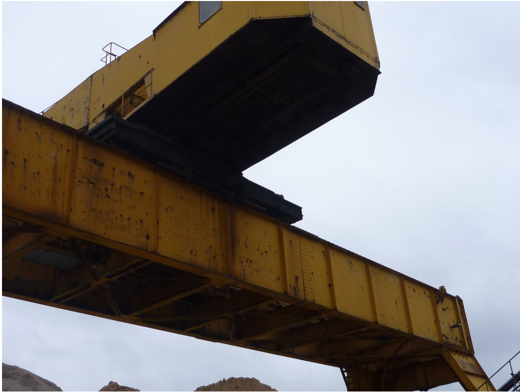
Flächenkorrosion
