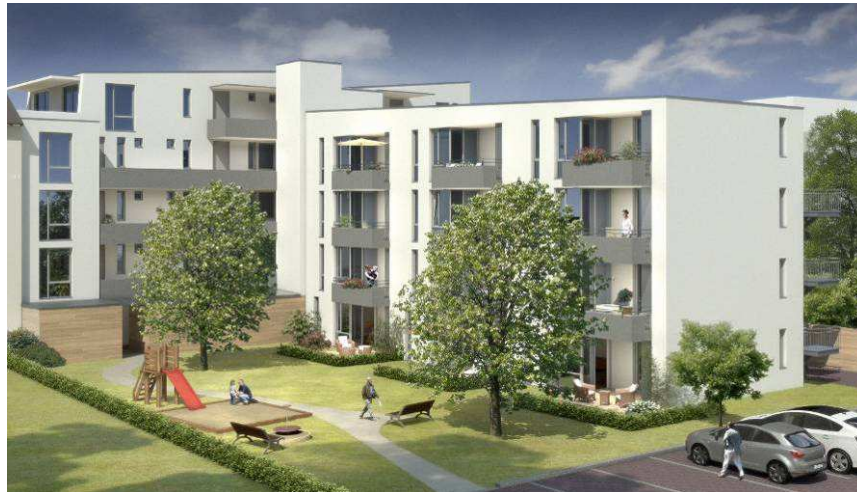
Abb. 12: Barrierefreies Neubauvorhaben der GEWOBA
