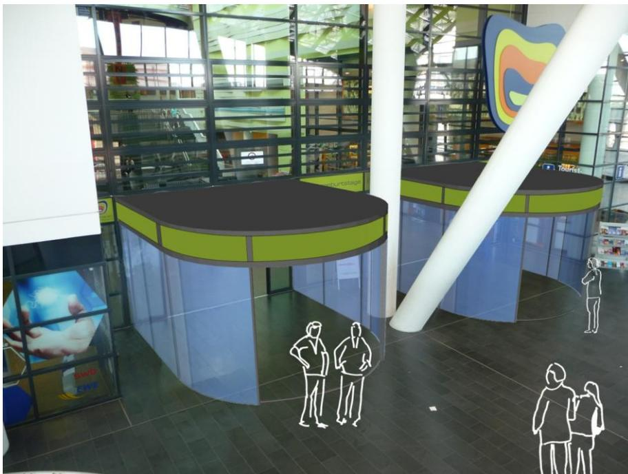
Im Shop-Bereich soll die Drehflügeltür durch eine schmalere zweiseitige Automatik-Schiebetür ersetzt werden, die den Luftquerschnitt verringert und durch kürzere Öffnungs- und Schließzeiten die Zugescheinungen eindämmen wird.
