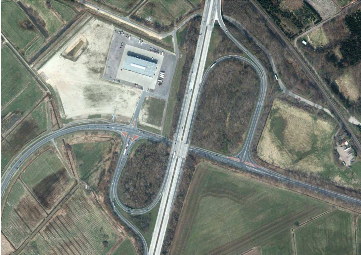
Abbildung 5: BAB A27, Anschlussstelle „Bremerhaven – Wulsdorf“ (Quelle: Luftbild BIS 2010)
