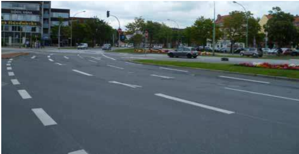
Elbinger Platz als Knotenpunkt von B212 und B6, auf PKW-Verkehr ausgerichtet, viele Spuren und großzügige Abbiegespuren, hohes Tempo
