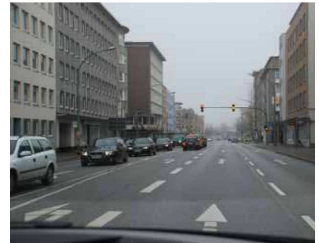
Lloydstraße, zentraler Zubringer von der Autobahn in die Innenstadt
