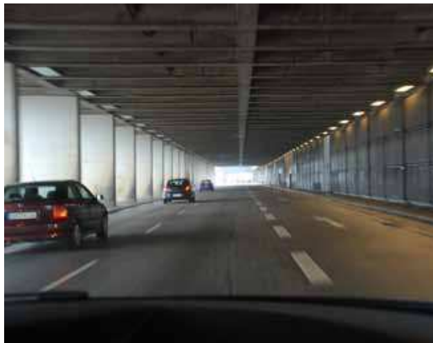
Columbusstraße Höhe Columbus-Center, durch Überkragung des Gebäudes Tunnelcharakter
