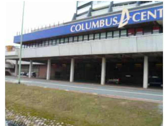
Columbusstraße mit Tunnel, kaum Qualitäten für den Fußgänger und Radfahrer
