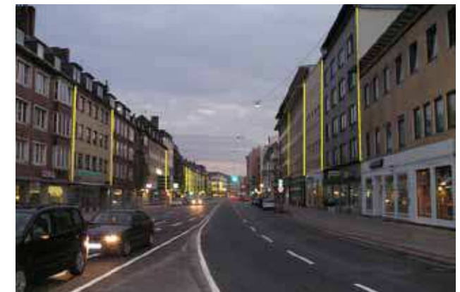
Georgstraße: Umbau und Beleuchtungskonzept
