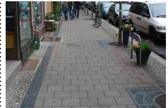
Zonierungen bei Breiten Straßenquerschnitten, Betonplatten und Mosaikpflaster
