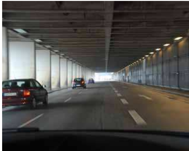
Tunnelcharakter, schlechter Sichtbezug zum Hafen, breite Fahrspuren führen zu hohen Geschwindigkeiten
