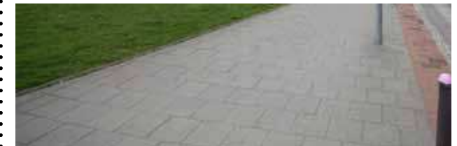
Oberflächen bei geringen Straßenquerschnitten, Betonplatten und Klinker
