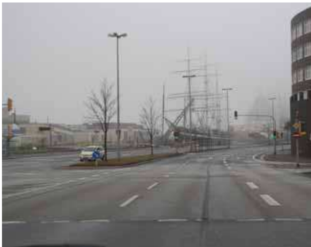
70 Überdimensionierter Kreuzungsbereich, hohe Geschwindigkeiten werden provoziert, aber attraktiver Blick auf Seute-Deern
