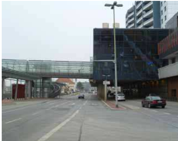
Großzügige Abbiegespuren im Bereich der Columbusstraße
