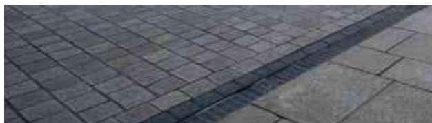
Kombination aus Platten außen und z.T. überfahrbarem Pflaster innen in Fußgängerzone
