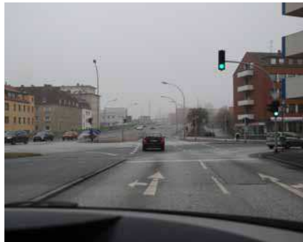
Columbusstraße Geestemünde, Busspur verbreitert den Verkehrsraum zusätzlich
